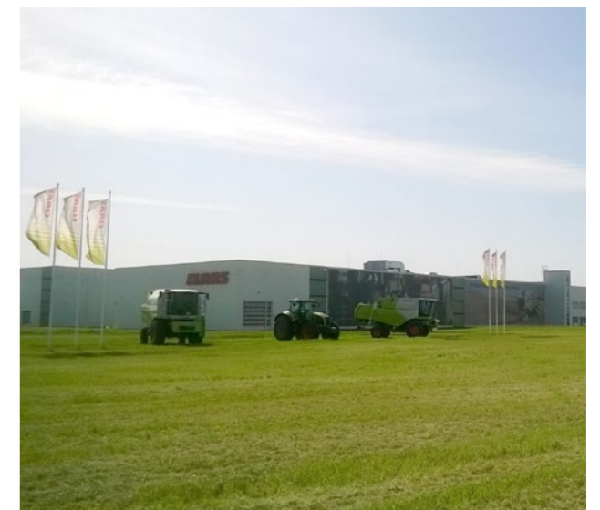
Biegen, schweißen, schneiden und fräsen – die beiden Führungskräfte begleiteten 825 Tage Bauzeit, in der die neue Fabrik in Krasnodar fertiggestellt wurde.
