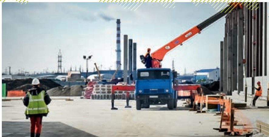
Der Ausbau der CLAAS Fabrik im russischen Krasnodar macht gute Fortschritte.
